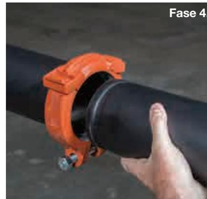
**Fase 4.** Far scivolare l'altra estremità del tubo nella guarnizione/nel giunto accertandosi che entri a contatto con l'arresto centrale della guarnizione stessa (vedere Figura 2). Entrambi i tubi dovrebbero essere allineati in senso verticale e orizzontale. Verificare che il corpo si trovi sopra la guarnizione e che le rispettive sporgenze siano interamente innestate nelle scanalature del tubo.
