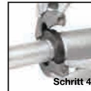
**Schritt 4:** Beide Schrauben entfernen und dann die Kupplungsgehäuse über der Dichtung positionieren. Sicherstellen, dass sich die Gehäuse über der Dichtung befinden und die Gehäusepassstücke vollständig in die Rohrleitungssegmenten hineinragen.
