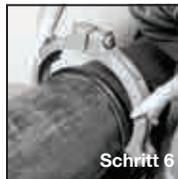
**Schritt 5:** Die Baugruppe über der Dichtung positionieren und so ausrichten, dass die Gehäusepassstücke vollständig in die Rohrleitungssegmenten hineinragen.
