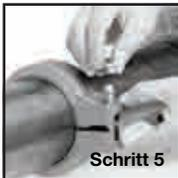
**Schritt 5:** Die andere Schraube und Mutter in die Kupplung einsetzen und beide Muttern fingerfest anziehen. Sicherstellen, dass die Schraubenköpfe einwandfrei in der Aussparung des Gehäuses versenkt sind.
